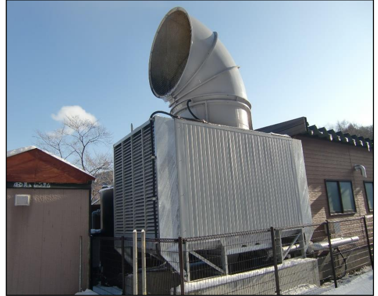
設備写真（発電後の集中配湯用温泉槽）
