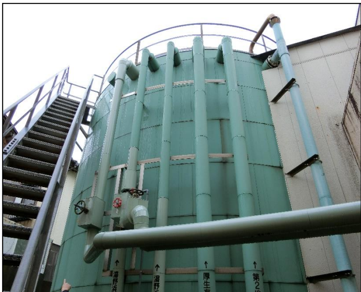
設備写真（温泉熱交換器）
