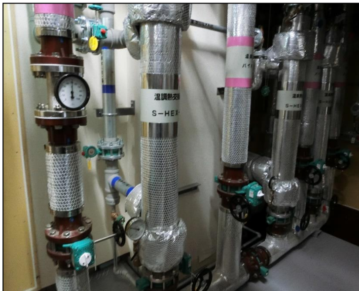
設備写真（温泉熱交換器）
