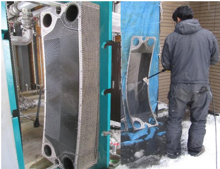
設備写真（熱交換器の洗浄）
