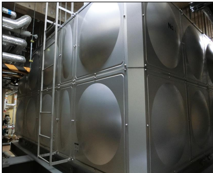
設備写真（貯湯槽）
