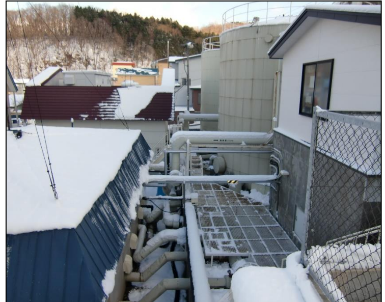
設備写真（発電後の集中配湯用温泉槽）
