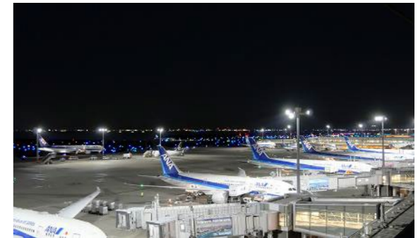
航空灯火・空港エプロン照明灯
